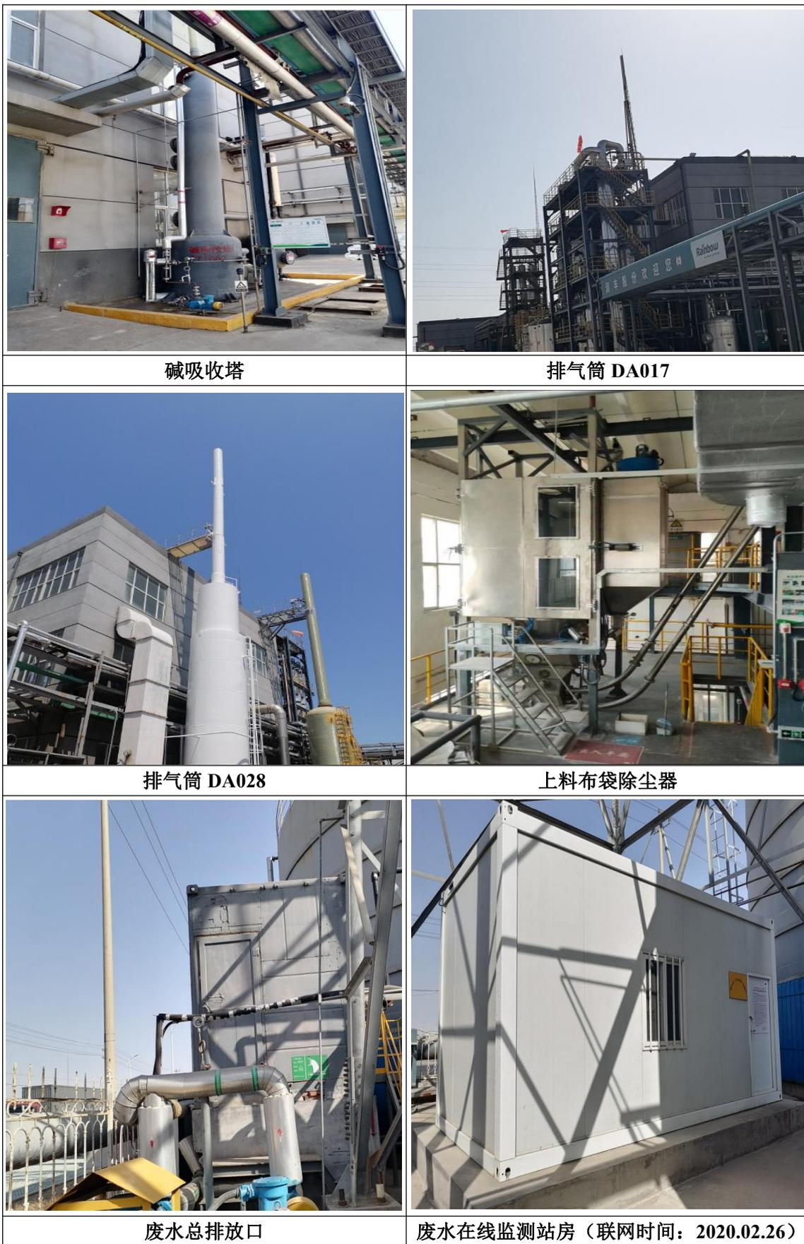
图 4.2-2 排气筒环保处理设施照片
