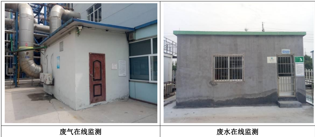
图 4.2-3 废气排放口及在线监测系统
